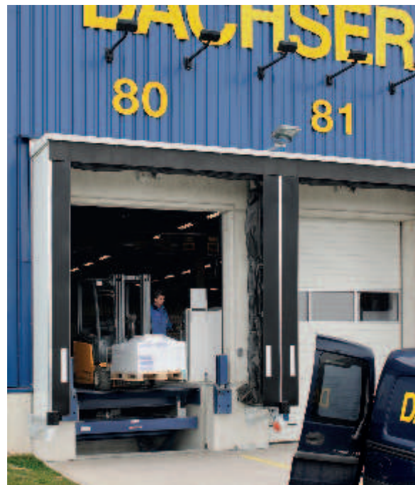
Der Liftleveler ist eine Kombination aus Vorschub-Ladebrücke und Scherenbühne
